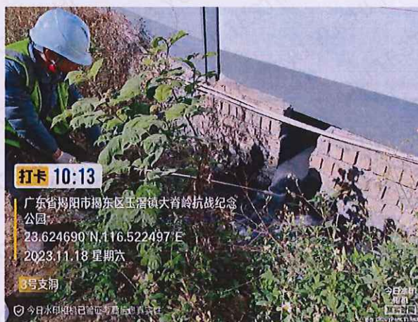
施工 1 标 3#支洞隧道洞口排水
