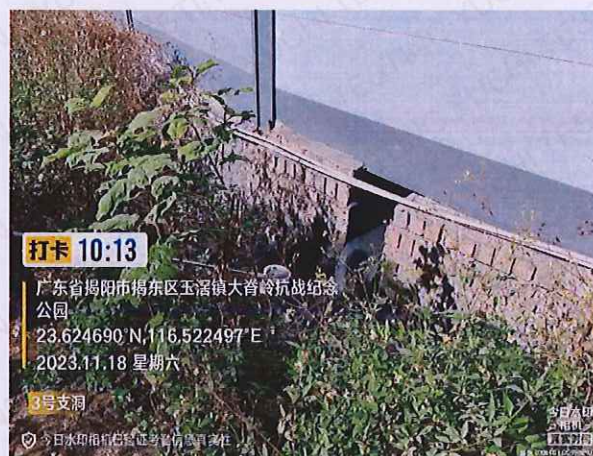
施工 1 标 3#支洞隧道洞口排水
